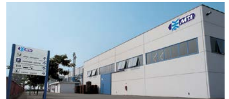
Bagnoli di Sopra (Padua)
